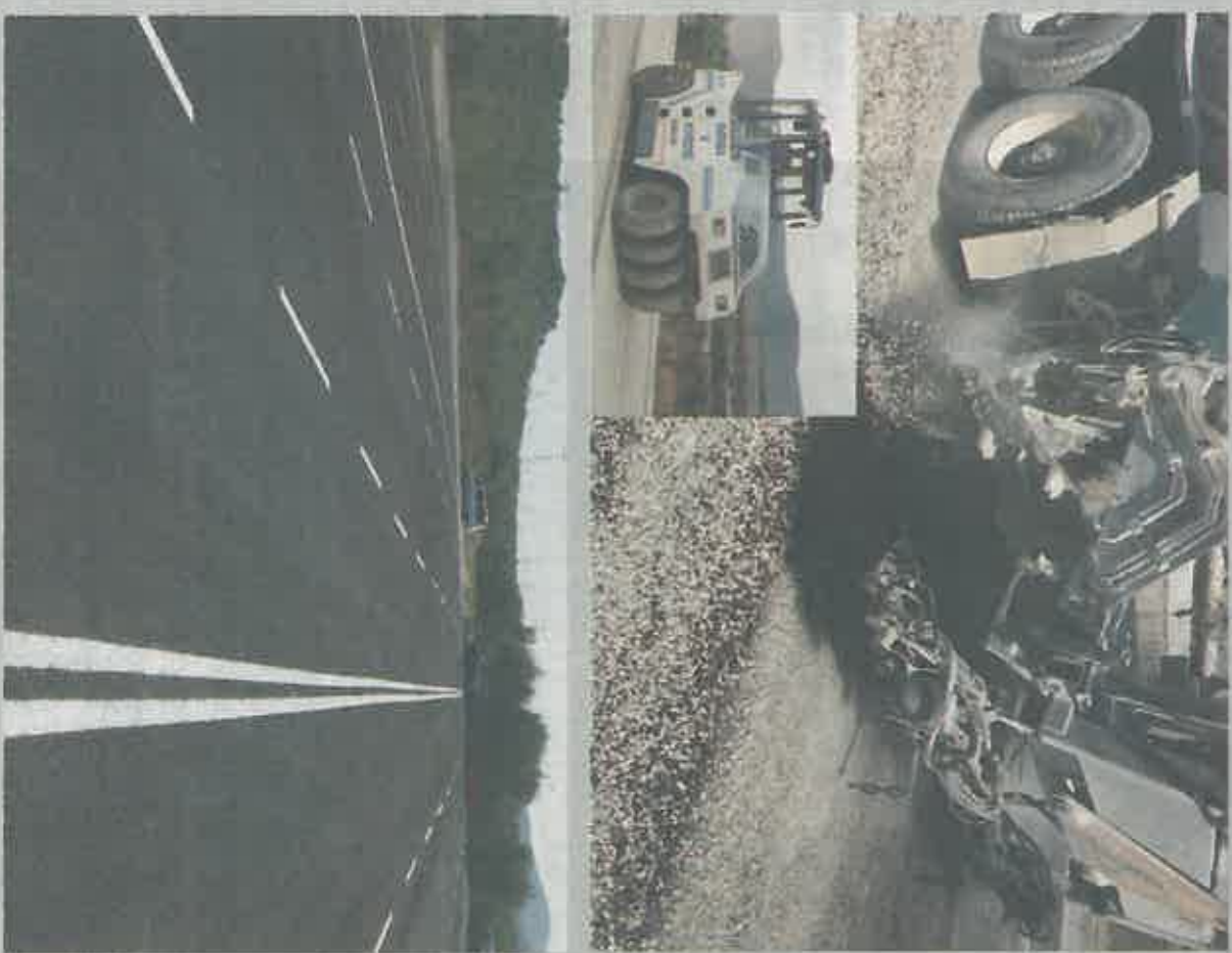
Фиг. 1. Двойна повърхностна обработка с последващ Fog seal бе положена върху трошенкоментна настилка на ТП паркинг с мощ 14 гка на площта на „Аерономикс“
